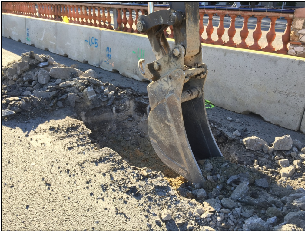
Fotografia 40. Excavació nivell de sauló UE602.
