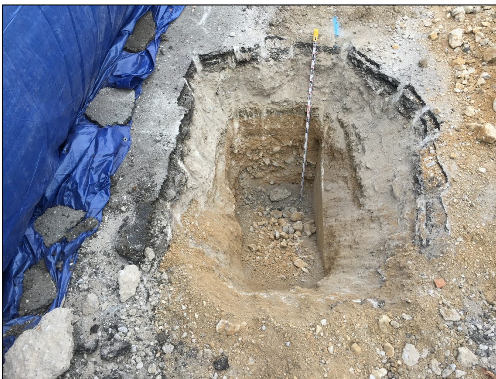
Fotografia 13. Vista en secció interior cala 2.
