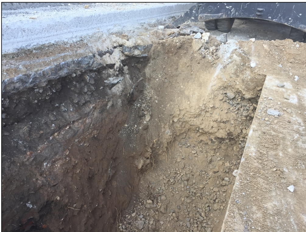
Fotografia 69. Vista de la rasa constructiva UE1005 i el seu rebliment de graves UE1003 en el tram de la plaça de Duc de Medinaceli.
