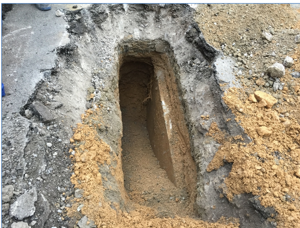
Fotografia 18. Vista en secció interior cala 3.
