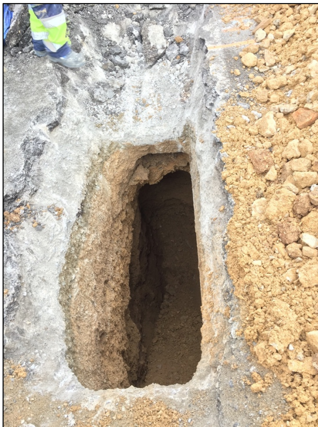
Fotografia 26. Vista interior cala 4.
