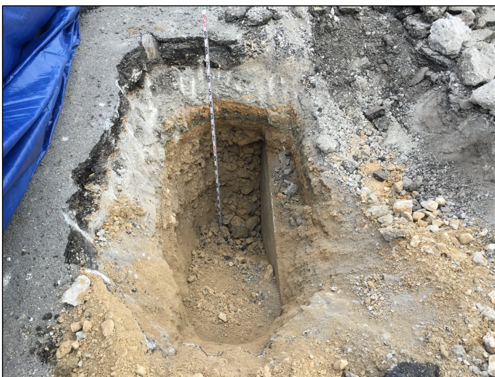
Fotografia 4. Vista en secció interior cala 1.
