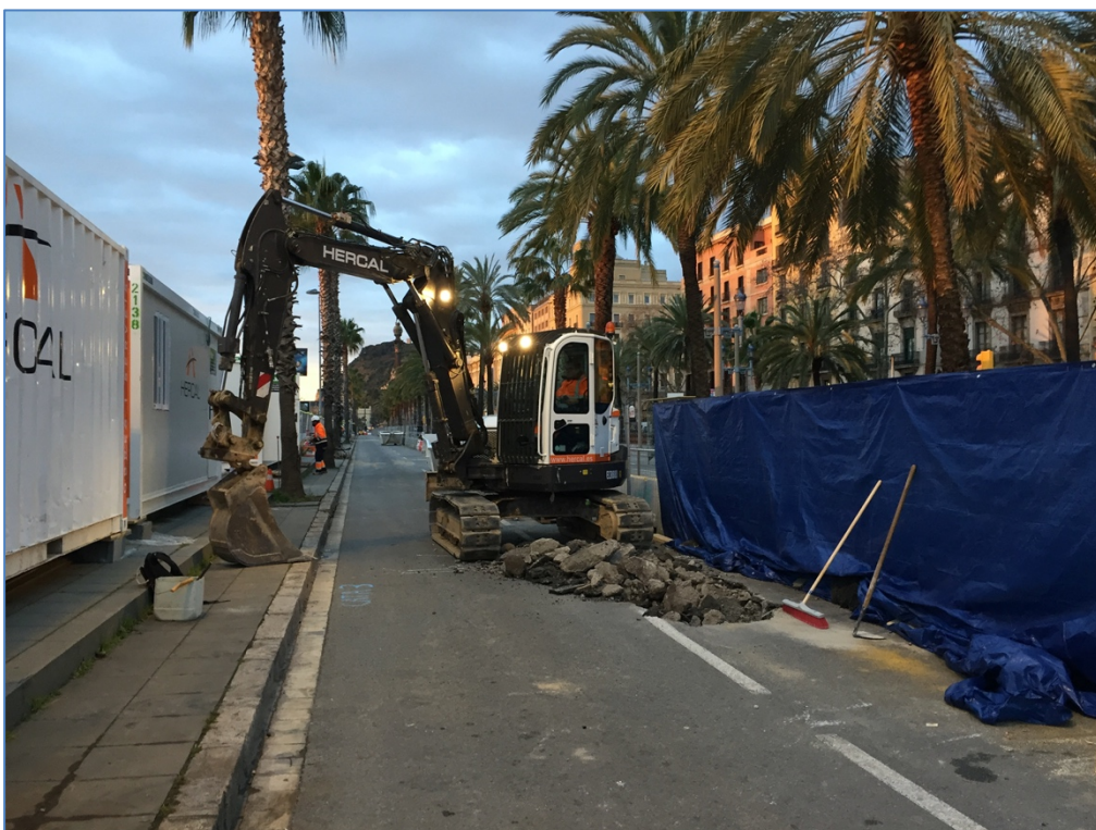
Fotografia 16. Obertura cala 3 amb aixecament asfalt UE300.
