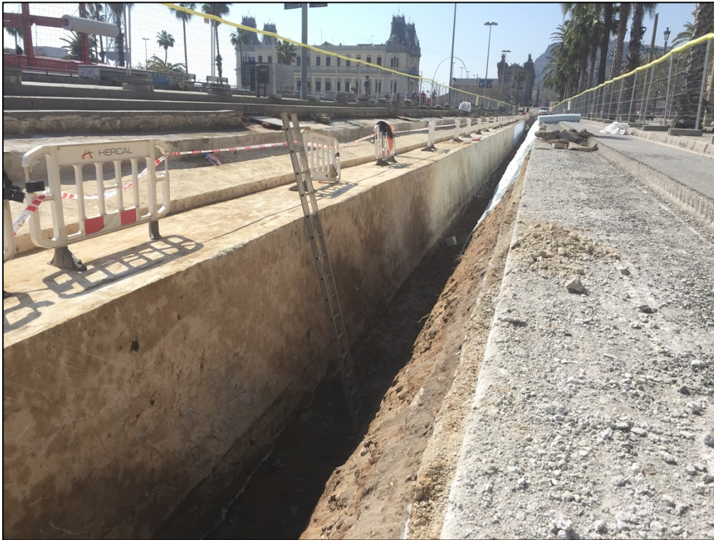
Fotografia 56. Vista tram rasa oberta.
