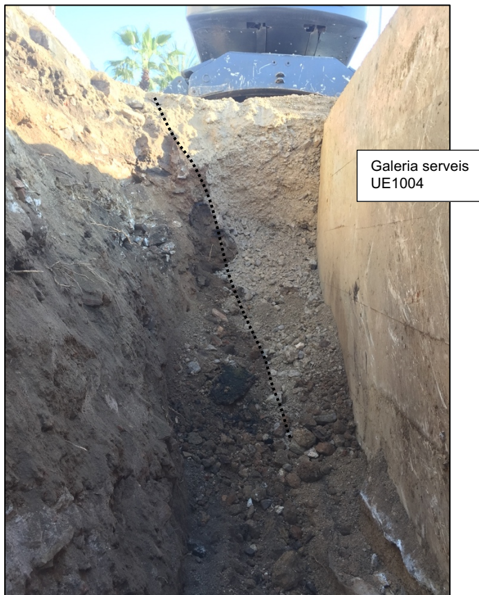
Fotografia 50. Rasa constructiva galeria serveis UE1005 i el seu rebliment UE1003.
