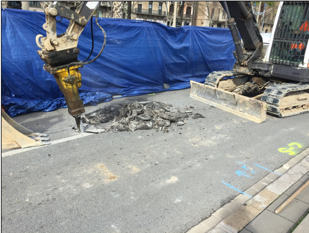
Fotografia 32. Rebaix pavimentació asfalt carrer UE500.
