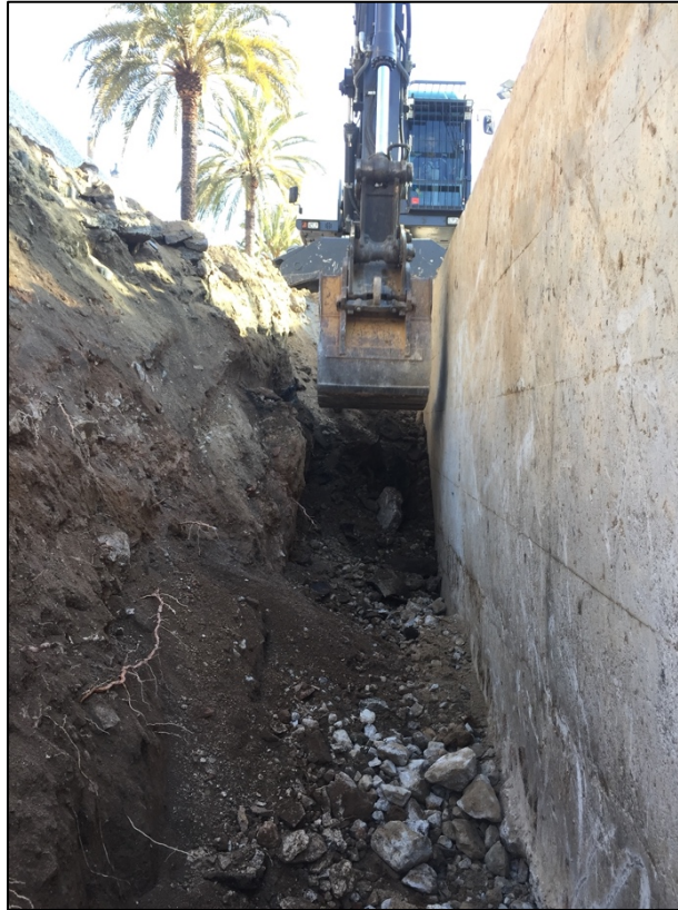
Fotografia 74. Vista interior de la rasa mentre es fa el rebaix.
