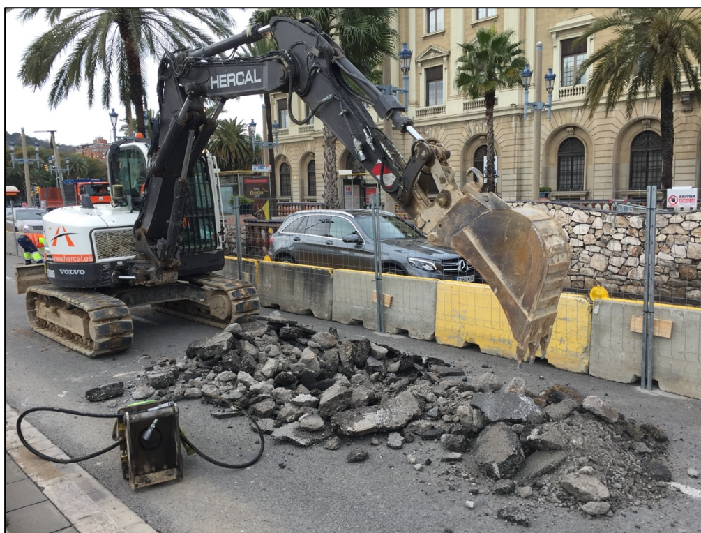
Fotografia 2. Rebaix pavimentació asfalt carrer UE100.
