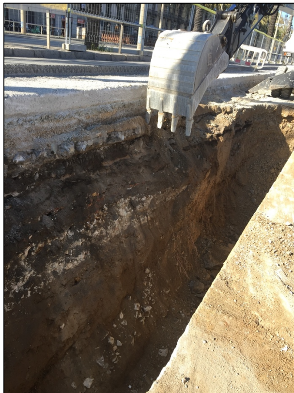
Fotografia 93. Treball de rebaix del talús de la rasa oberta en la zona de la plaça del Duc de Medinaceli. No es documenten restes del baluard de Sant Ramon.
