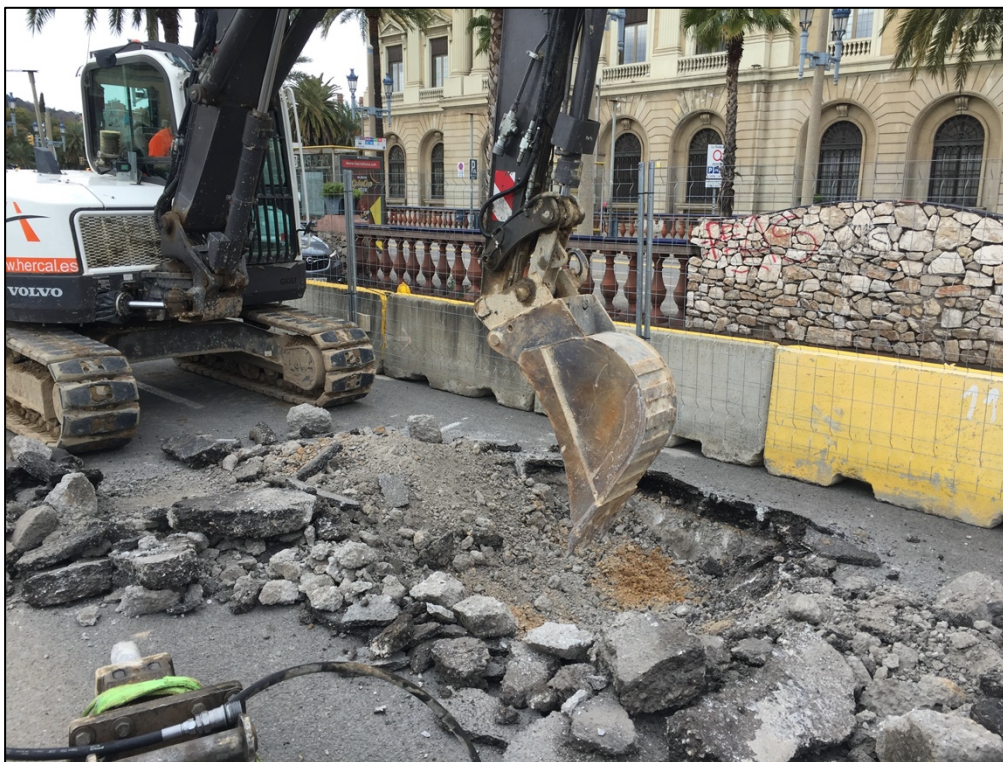
Fotografia 3. Rebaix nivell de sauló UE102.
