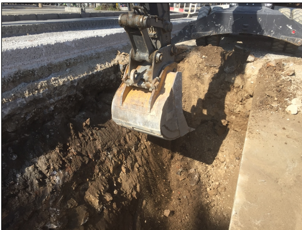
Fotografia 59. Rebaix rebliment de graves de la rasa constructiva UE1003.
