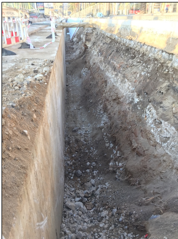
Fotografia 100. Vista tall estratigràfic tram final rasa oberta.
