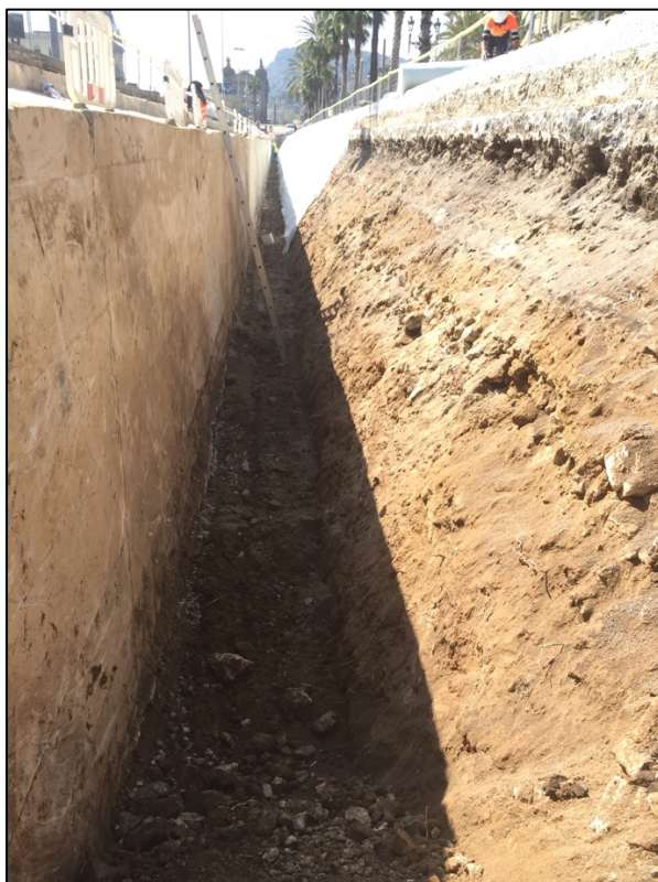
Fotografia 58. Interior rasa oberta amb galeria de serveis de formigó UE1004.
