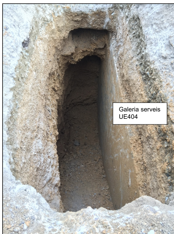
Fotografia 29. Vista de la galeria de serveis en el tram d la cala 4.
