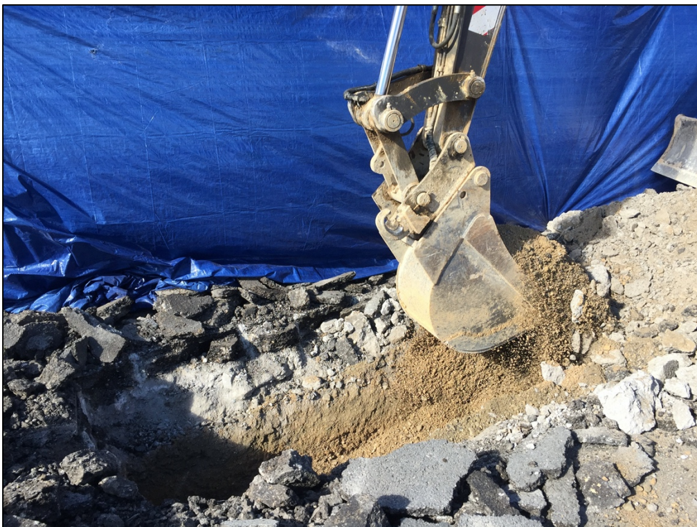
Fotografia 33. Obertura cala 5 i excavació nivell de sauló UE503.
