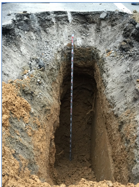
Fotografia 19. Vista en secció interior cala 3.
