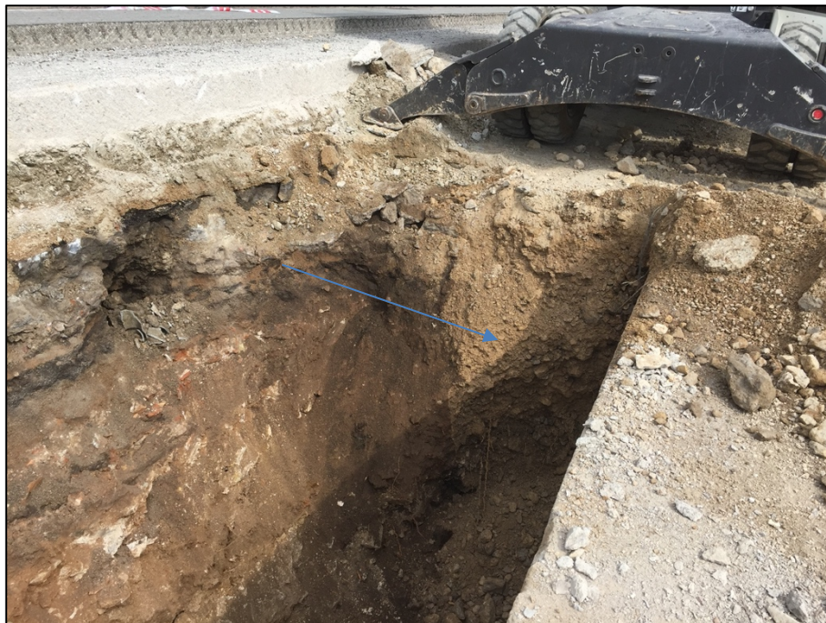
Fotografia 95. Vista de la rasa constructiva de la galeria de serveis UE1005 i el seu rebliment de sauló UE1003.
