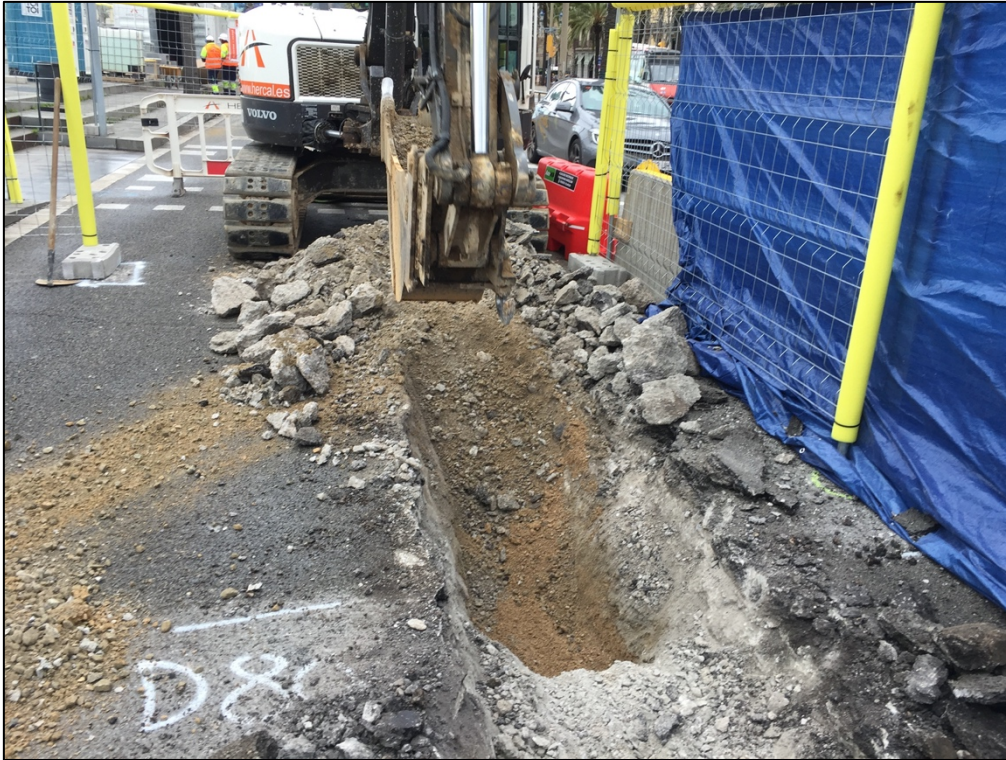
Fotografia 24. Obertura cala 4 amb extracció dels nivells de sauló UE402 i UE403.
