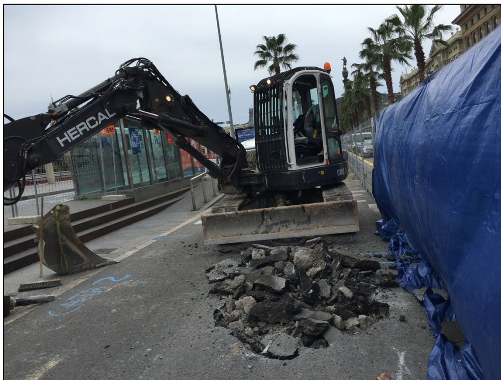
Fotografia 9. Rebaix pavimentació asfalt carrer UE200.
