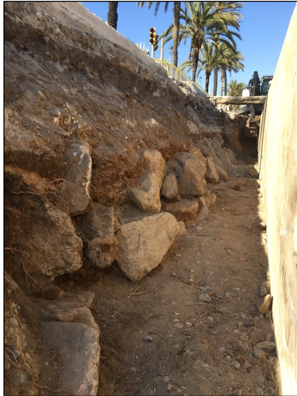
Fotografia 80. Vista els grans blocs de pedra UE1014 des de l'interior de la rasa oberta.
