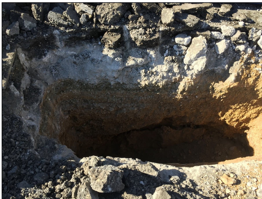
Fotografia 35. Vista en secció interior cala 5.
