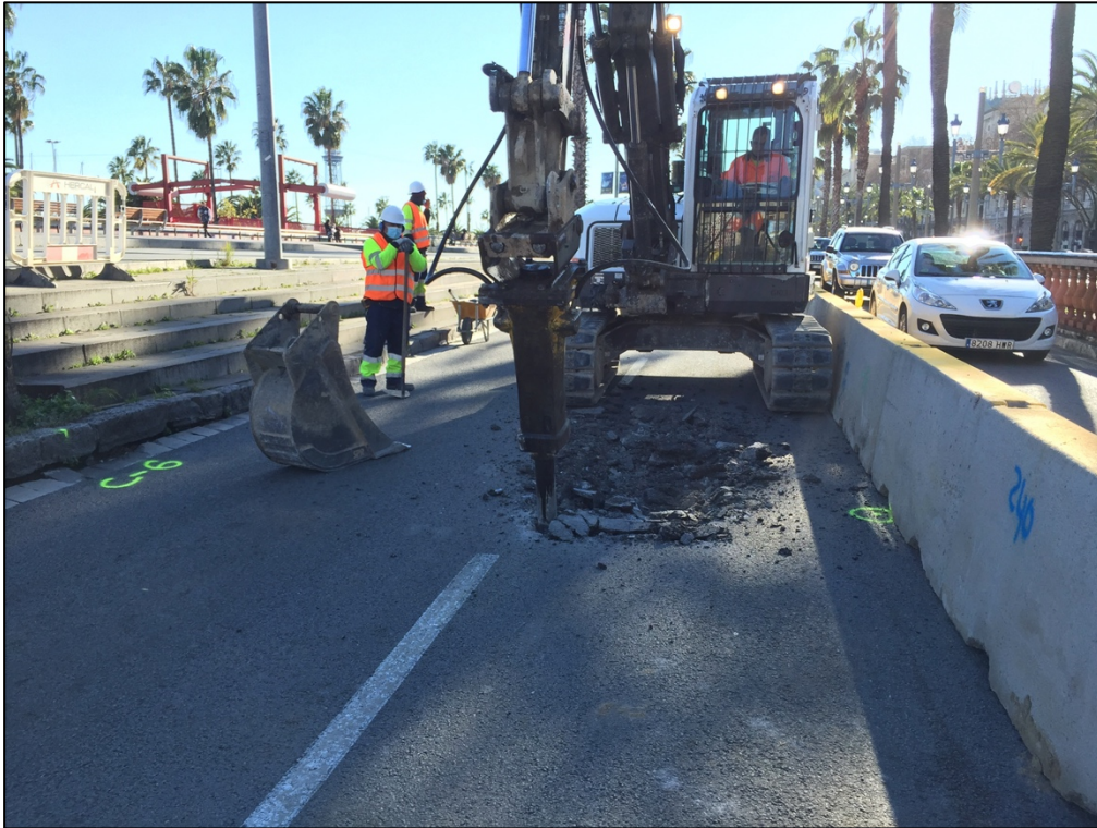
Fotografia 39. Obertura cala 6 amb aixecament asfalt carrer UE600.
