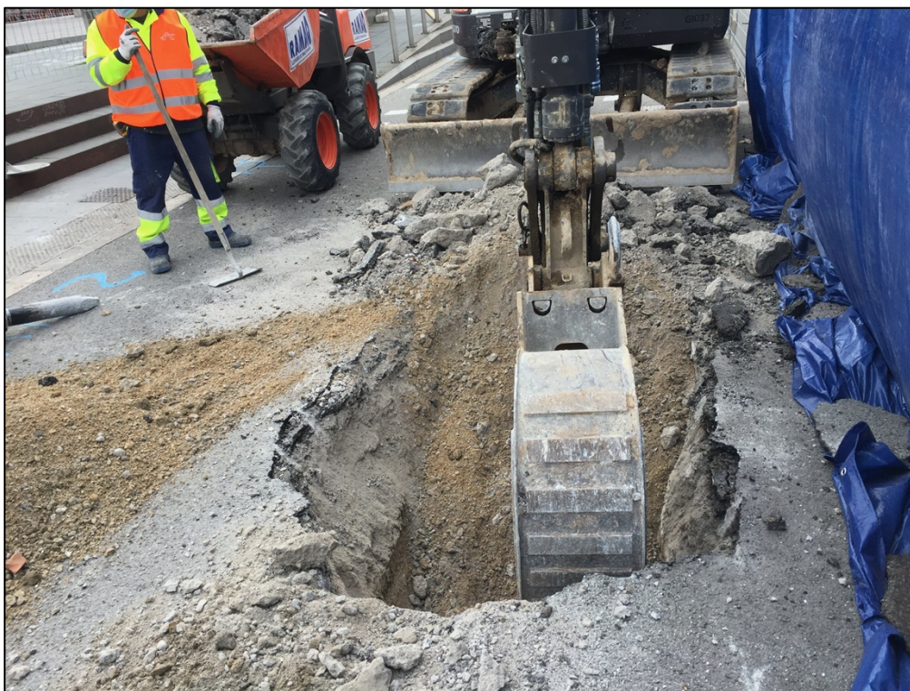
Fotografia 11. Rebaix nivell de sauló UE202.
