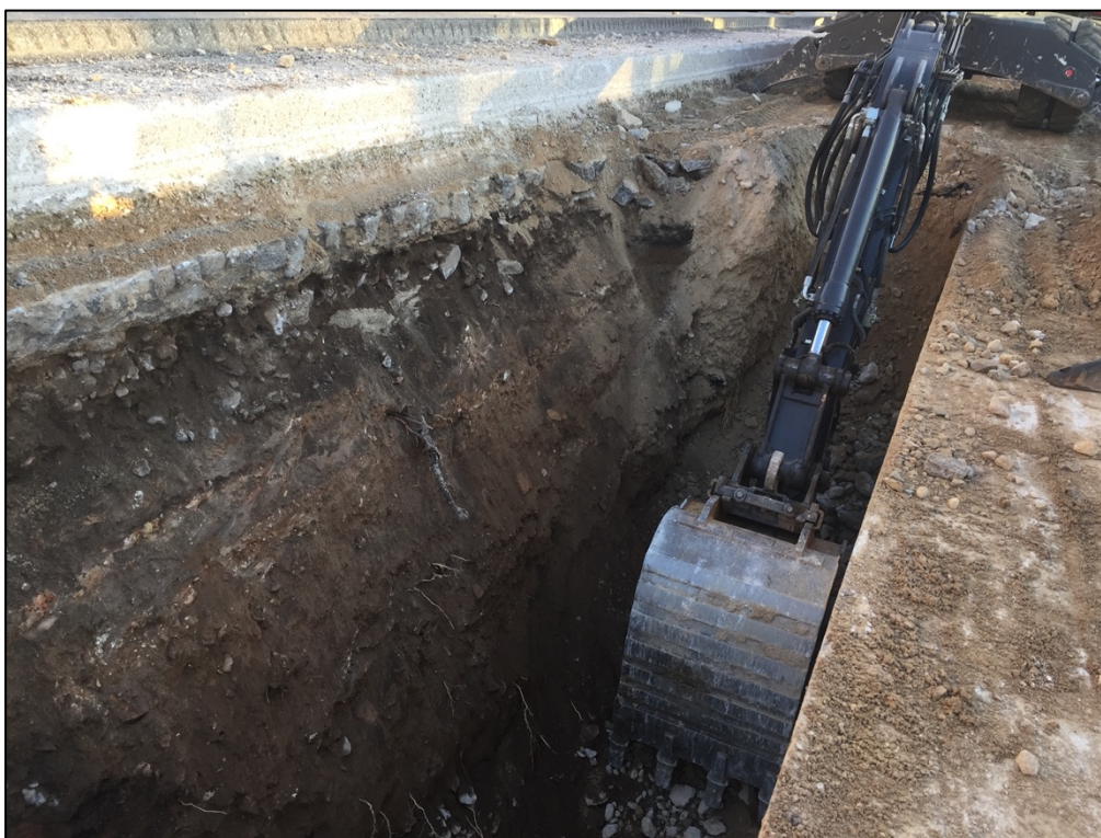
Fotografia 68. Rebaix rasa en la zona de la plaça del Duc de Medinaceli.
