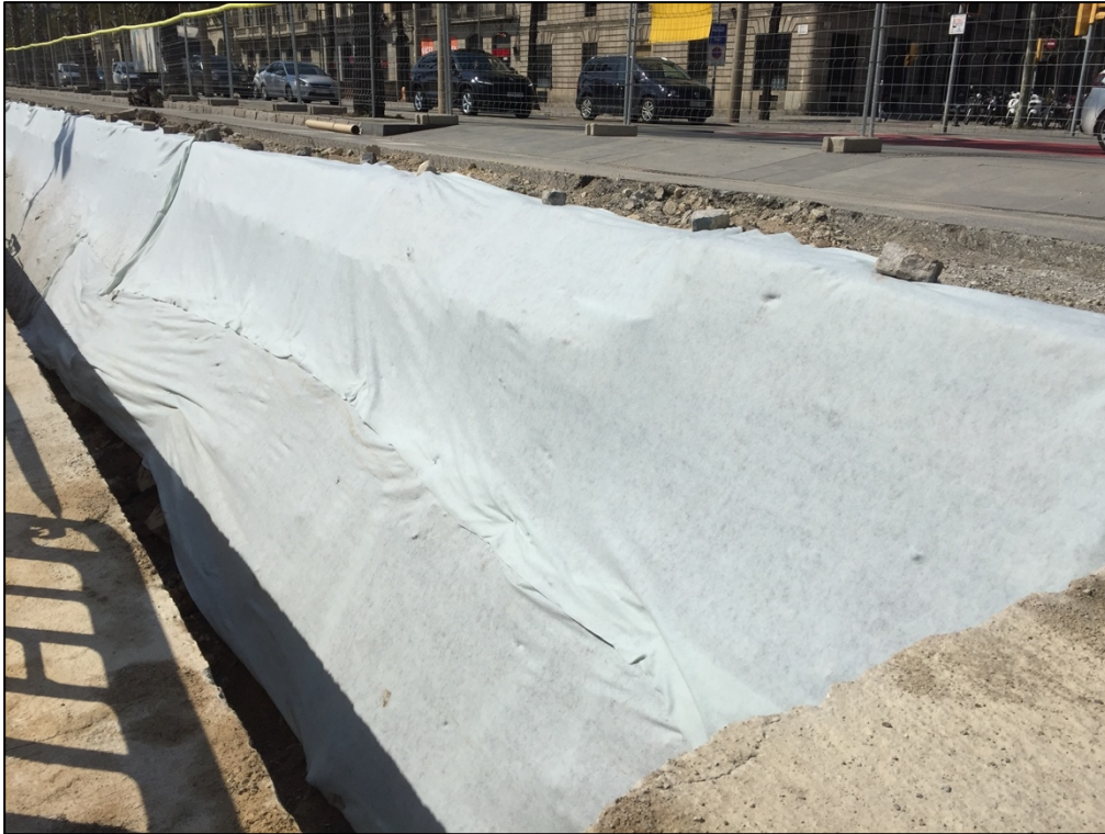
Fotografia 102. Cobriment amb geotèxtil del talús rasa oberta.
