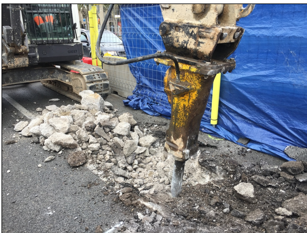
Fotografia 23. Rebaix paviment actual carrer UE4000.
