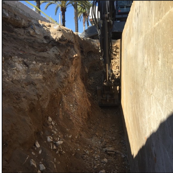
Fotografia 92. Interior rasa en el tram de la plaça Duc de Medinaceli un cop passats els blocs de pedra UE1014.
