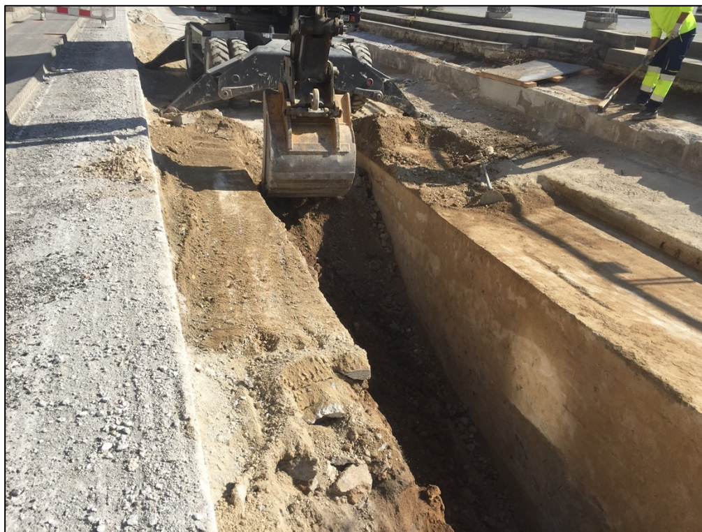
Fotografia 51. Obertura rasa amb màquina retroexcavadora.
