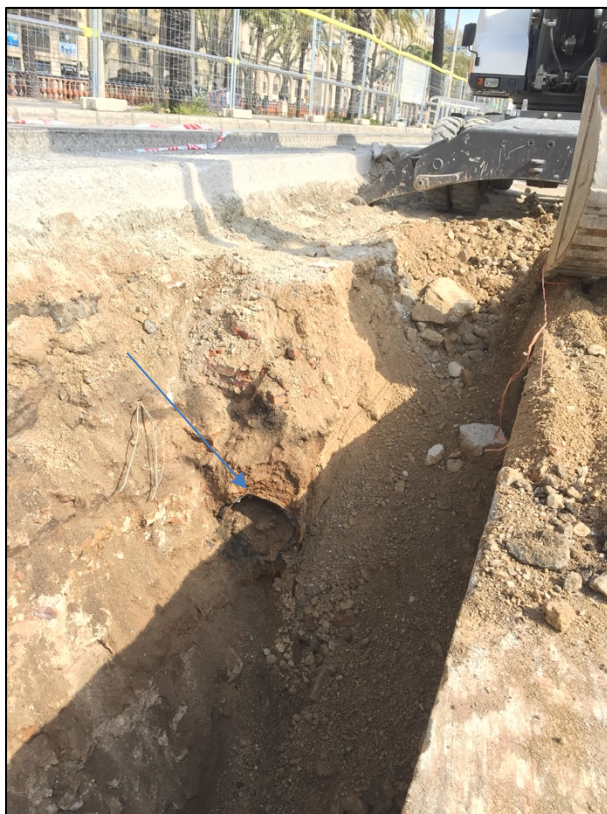
Fotografia 96. Localització canalització d'hidrocarburs UE1013.
