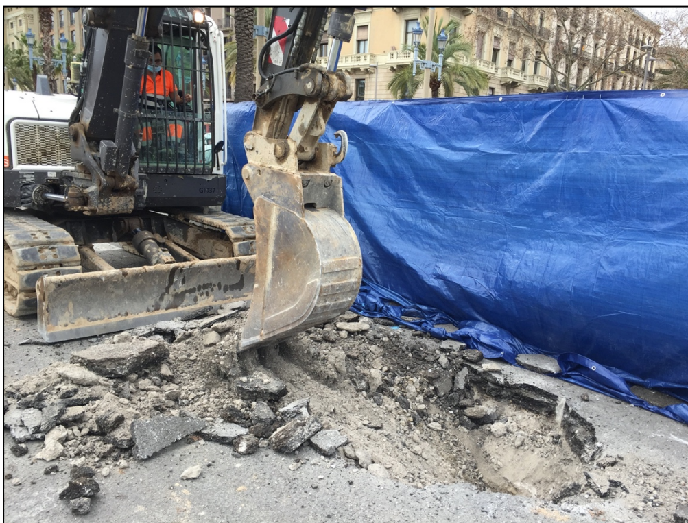
Fotografia 10. Rebaix cala amb nivells de preparació del paviment actual.
